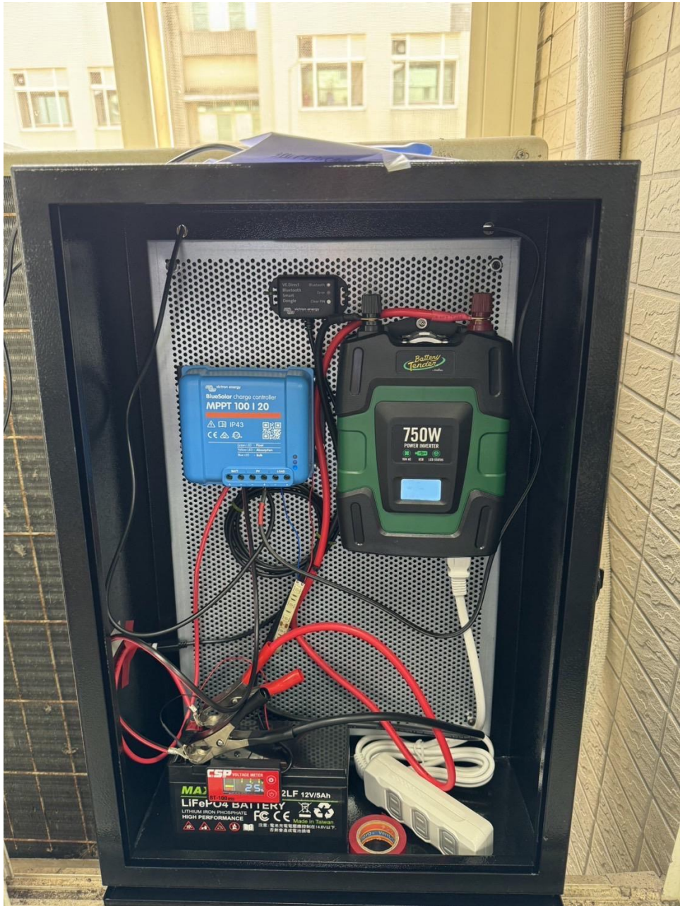
圖九、本研究建置之太陽能發電及蓄電系統
