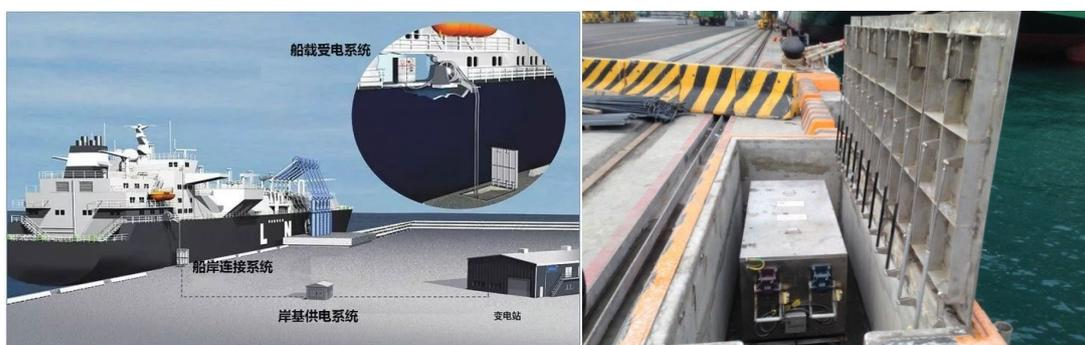
圖 10、11:岸電系統(左)及岸電設施(右)，資料來源:Google 圖片
